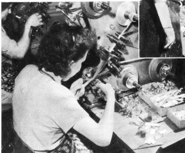
Bild 5. Wickeln von Rollkondensatoren
